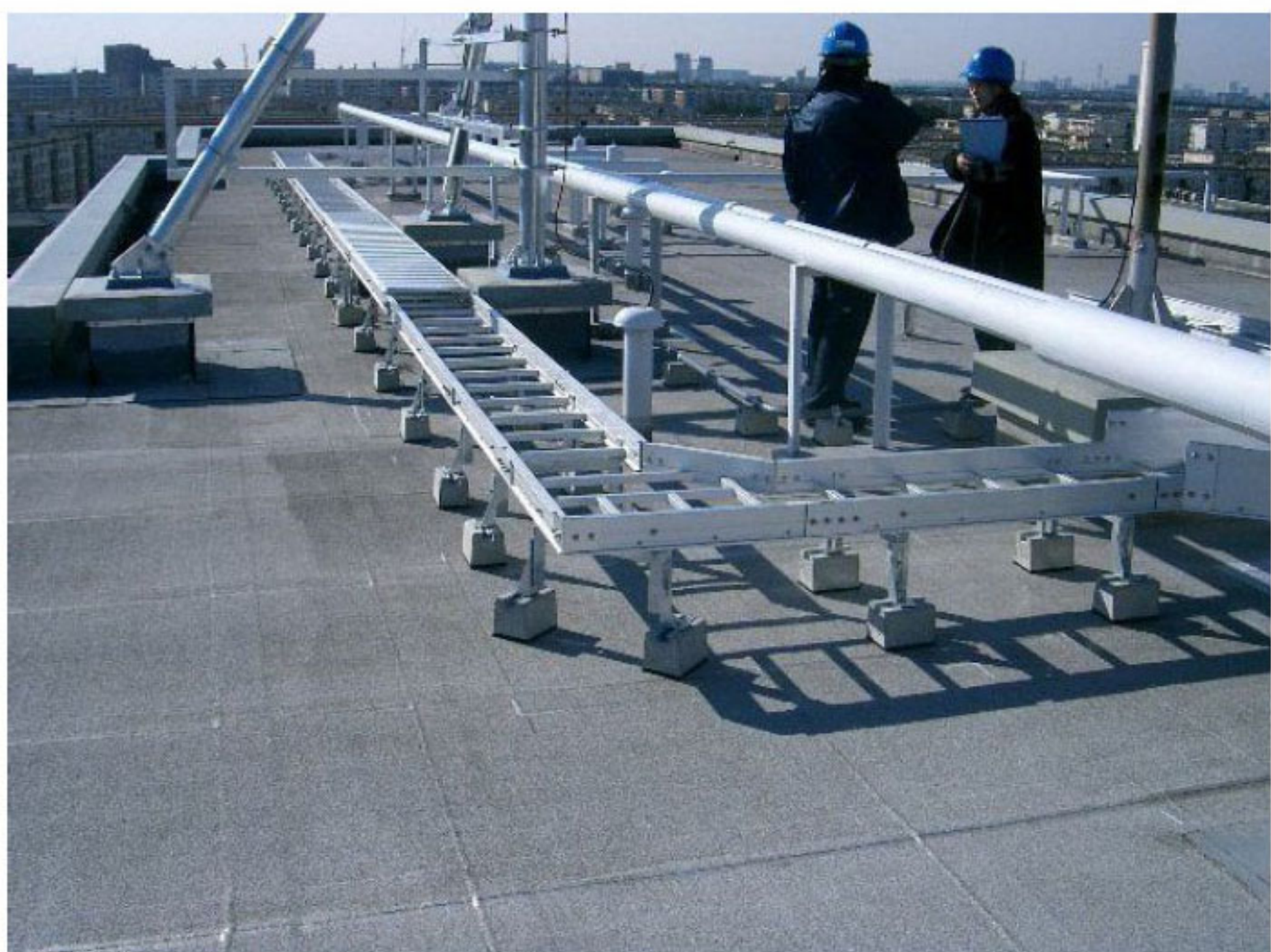
【屋上水平部】 アルマイトクリア 歩行用カバー＋滑り止めテープ
