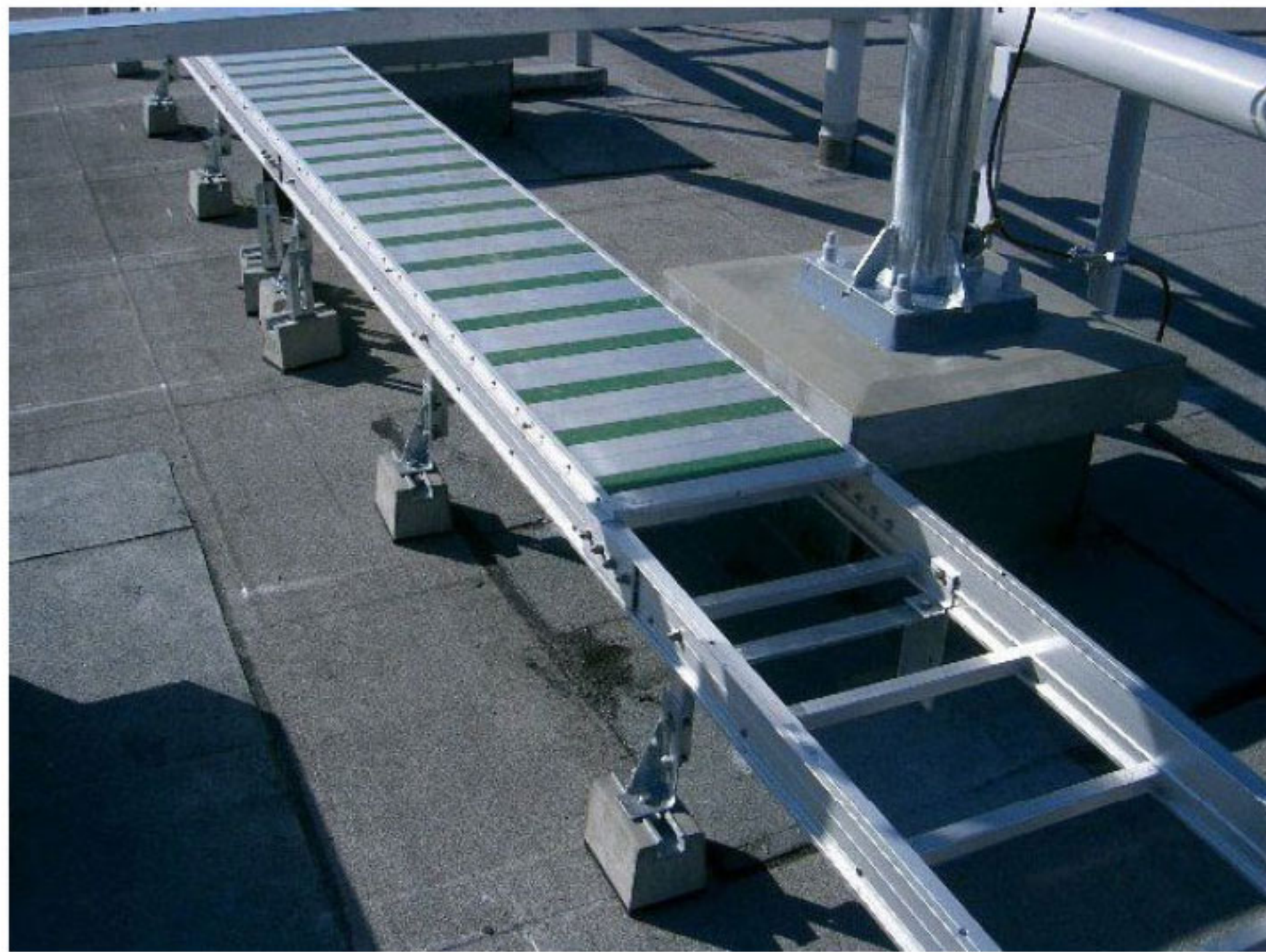
【屋上水平部】 アルマイトクリア 歩行用カバー＋滑り止めテープ
